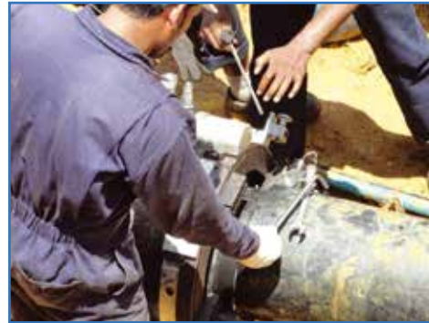
DLW utilisation sur le site de gazoduc
